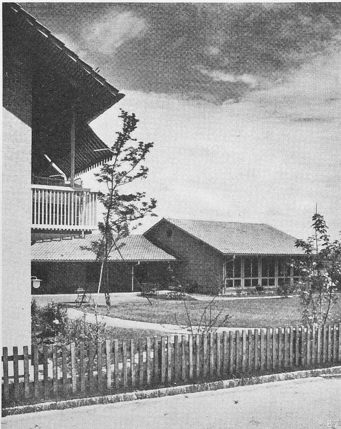
Bild 2. Nebenbau mit Tages- und Wirtschaftsräumen aus Südwesten
