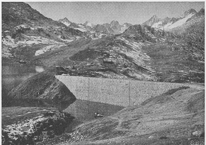
Bild 38. Staumauer Trübensee, 20. Oktober 1949
