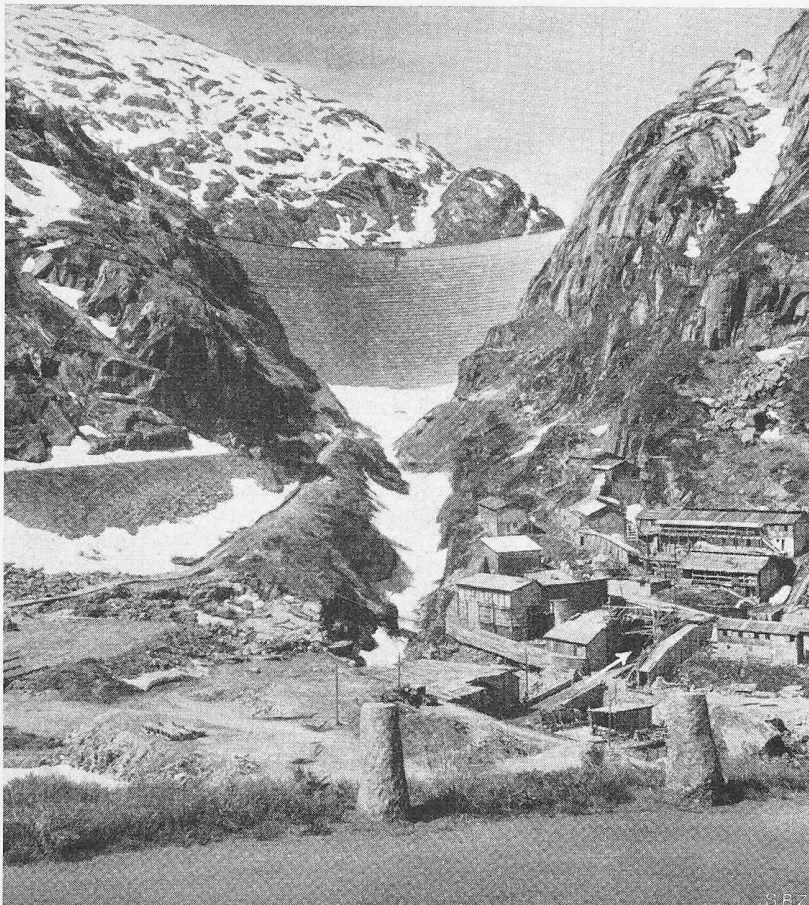
Bild 60. Die Baustelle im «Sommerloch», unterhalb der Spitalammperre, am 12. Juni 1952. Der weisse Pfeil zeigt von der Zufahrtsbrücke zur Mündung des Hauptzuganges in die Zentrale Grimsel
