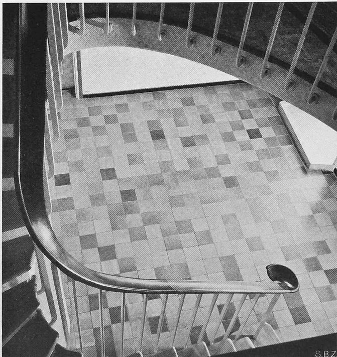
Eingangshalle, Böden aus roten Eternitplatten
