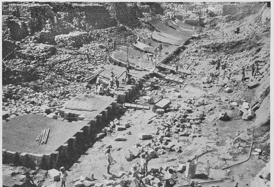
Bild 26 (links oben), Hirakud-Sperre, Abtransport des Aushubes, kleinere Ausbruchstücke durch Frauen auf dem Kopf (Vordergrund), grössere durch Männer mit Tragbalken (Mitte). — Bild 27 (links unten), Hirakud-Sperre. Sikh als Führer eines 10 m 3 Le Tourneau-Scrapers. Die Sikhs sind kenntlich am charakteristischen, die Ohren bedeckenden Turban und der Bartracht, Sie gehören einer Religion an, die eine Synthese zwischen Hinduismus und Mohammedanismus darstellt. In mancher Beziehung können die Sikhs als Elite gelten. Photos Ros. — Bild 28 (rechts), Tungabhadra-Sperre, Mauerwerk aus Granit, Blick auf die Ueberfallpartie, Ausführen der Granitverkleidung. Photo E. Gruner
