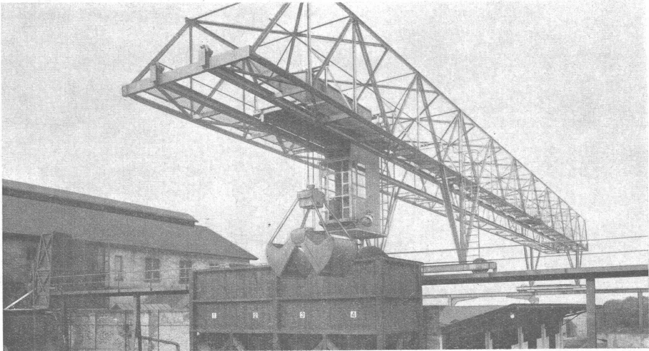
Verladebrücke in Schweisskonstruktion 2,5 t Tragkraft, 46 m Länge
