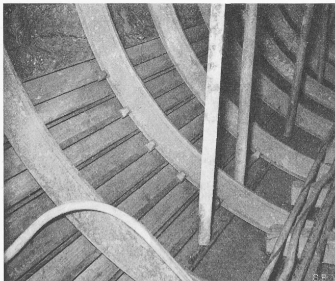
Bild 5. Teilpartie der Schalung für einen runden Stollen mit vorfabrizierter Sohle
