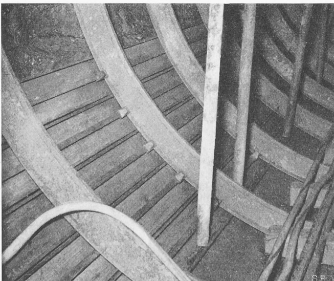
Bild 5. Teilpartie der Schalung für einen runden Stollen mit vorfabrizierter Sohle
