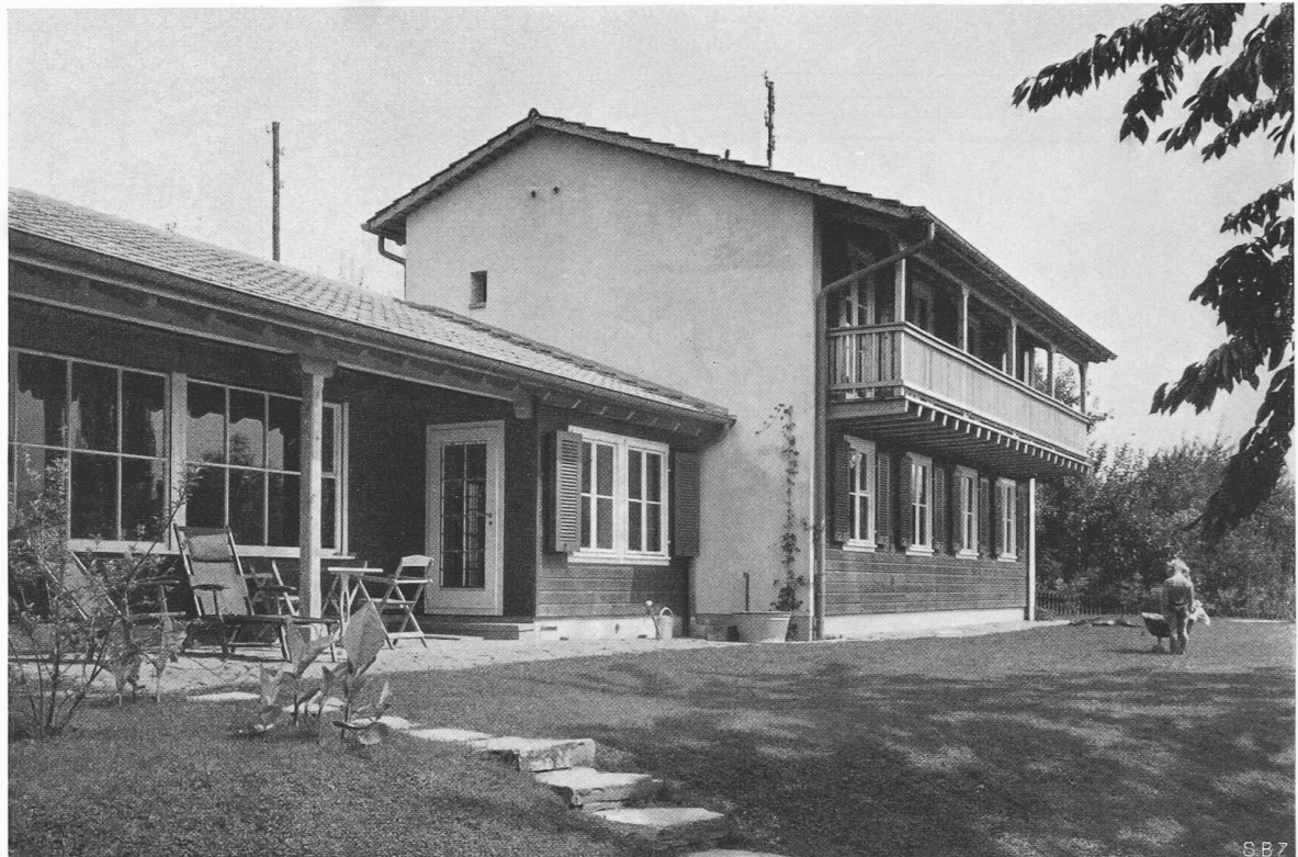
Bild 5. Ansicht von Südwesten
