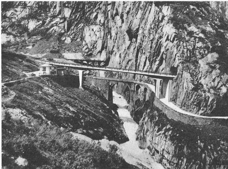
Bild 10. Rahmenbrücke aus Spannbeton (vgl. Bild 7)
