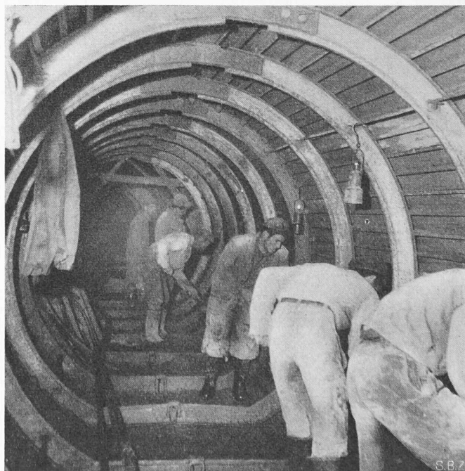
Bild 8. Leichtmetallschalungen für die Stollenbetonierung
