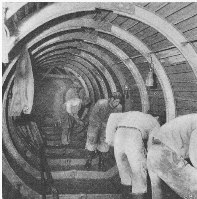
Bild 8. Leichtmetallschalungen für die Stollenbetonierung
