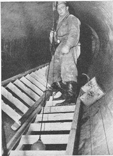
Bild 9. Schweissnahtprüfung im Druckschacht. Die Kapsel mit dem Iridium-Isotop wird mittels einer Stahlrute aus der Bleibombe herausgezogen
