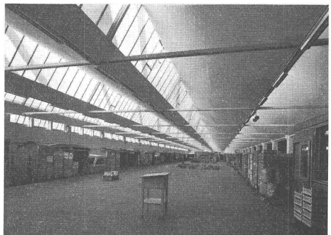
Shedbau für Lagerhalle
