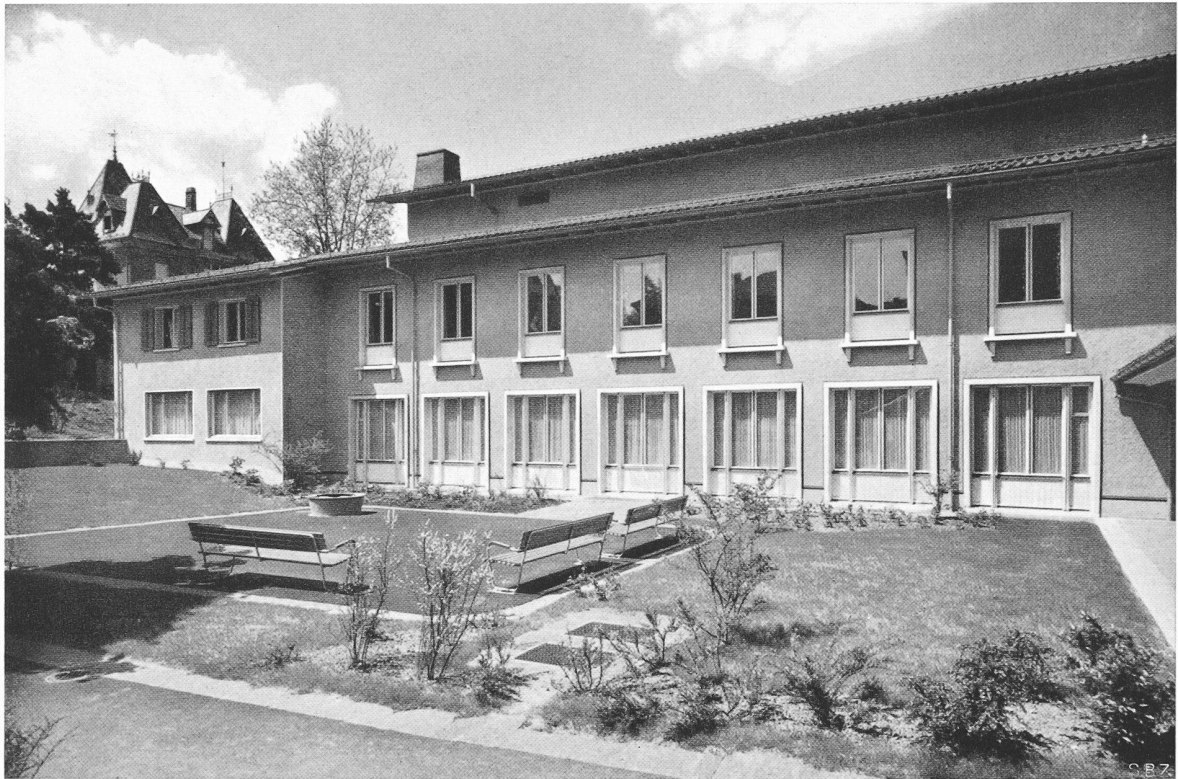
Kirchgemeindehaus in Zürich-Oerlikon, Südostfassade mit Garten auf Seite Volkshaus
