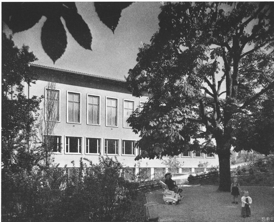
Nordwestfassade von der öffentlichen Anlage aus
