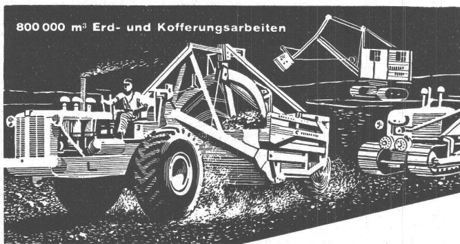
Bauunternehmungen If Flughafen Kloten
