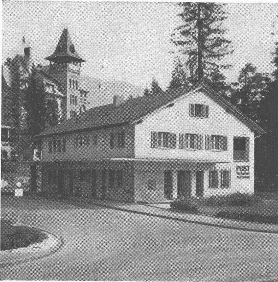
Belagsarbeiten Post Flims-Waldhaus
