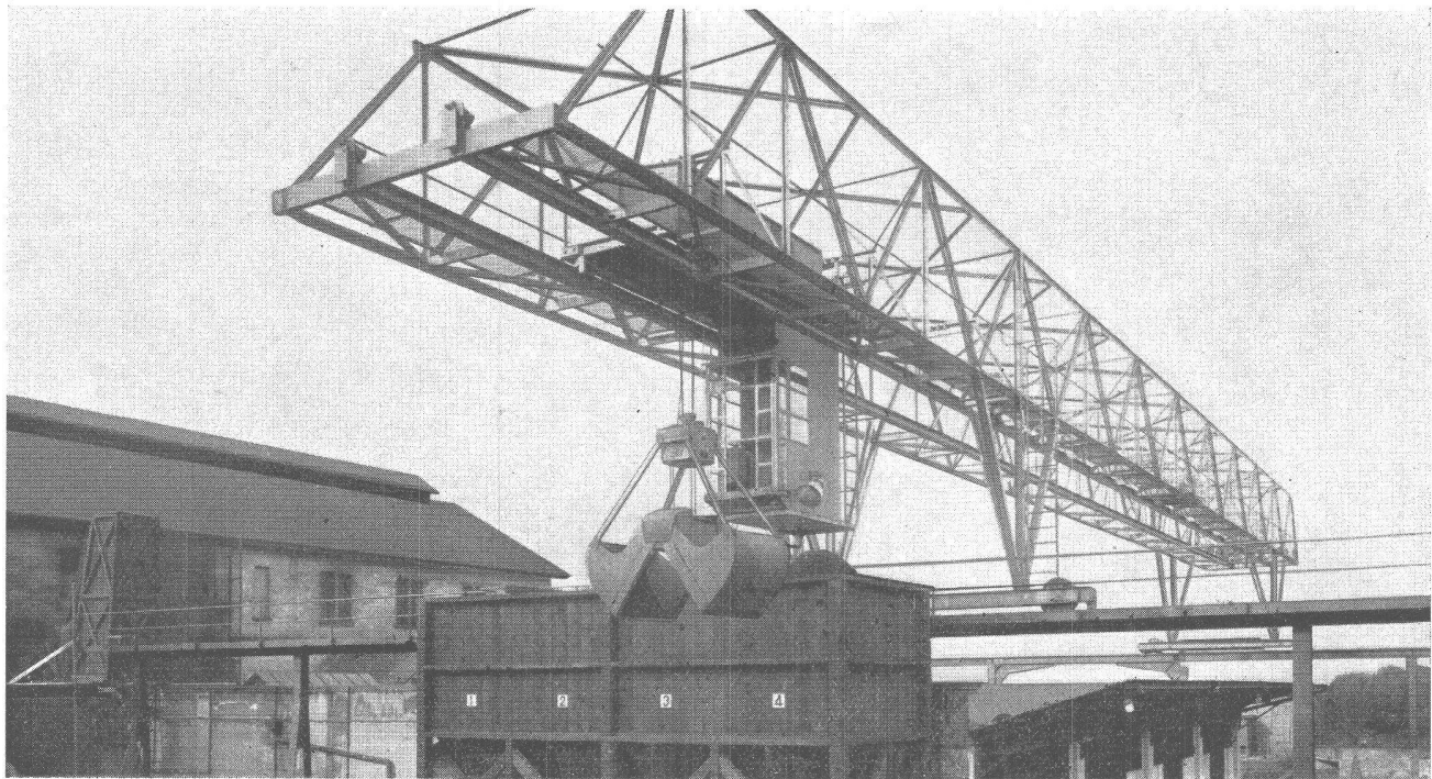
Verladebrücke in Schweisskonstruktion 2,5 t Tragkraft, 46 m Länge
