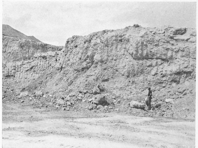
Bild 10. Grundmoräne im Abbau für das Kernmaterial des Erddammes Marmorera. Photo E. Brügger, VAWAG
