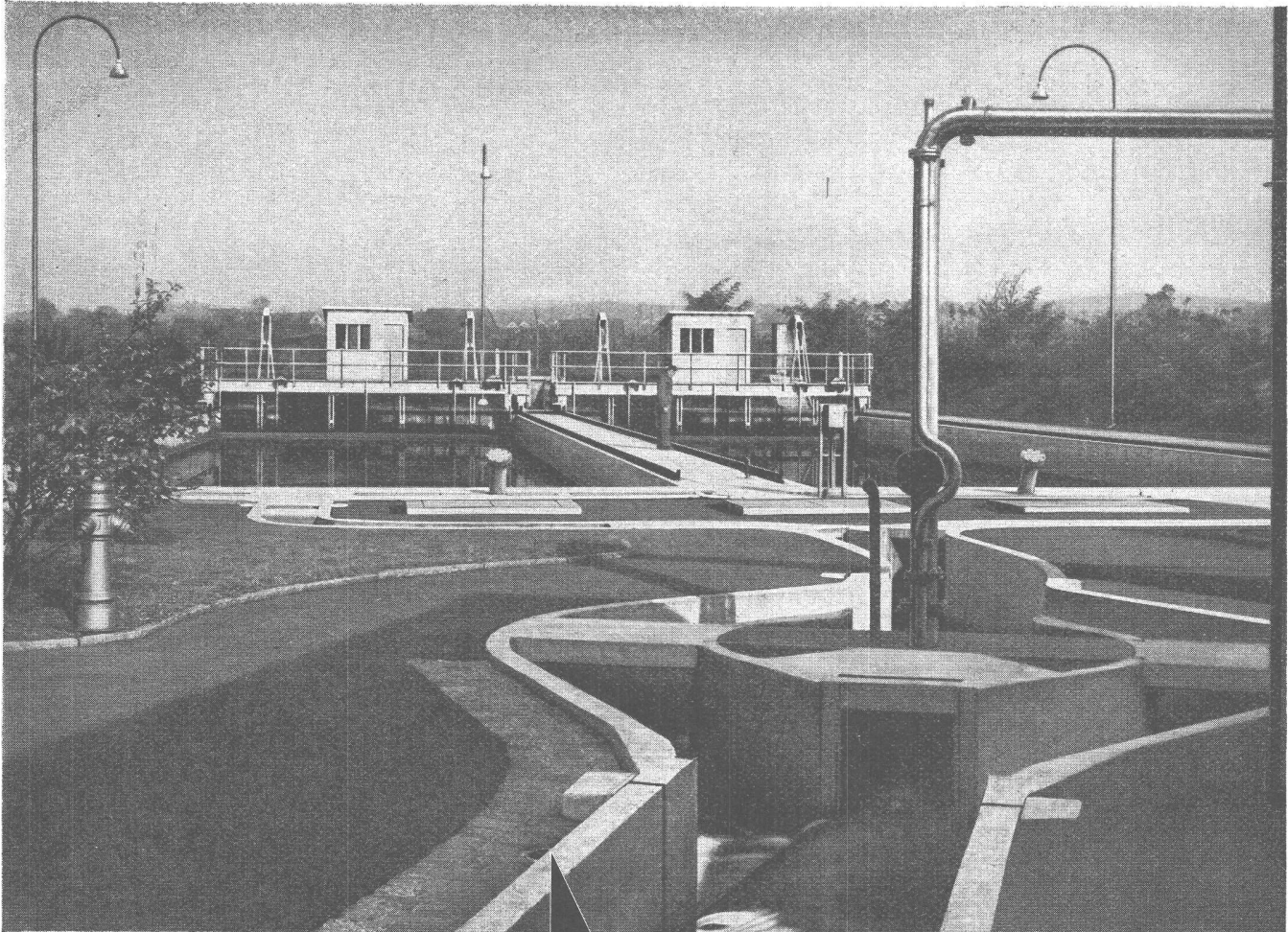
Vertikal-Sandfang und Absetzbecken Dessableur vertical et clarificateurs
