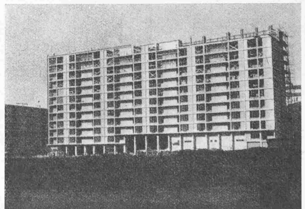
Bâtiment D à 13 étages, 15 décembre 1952
