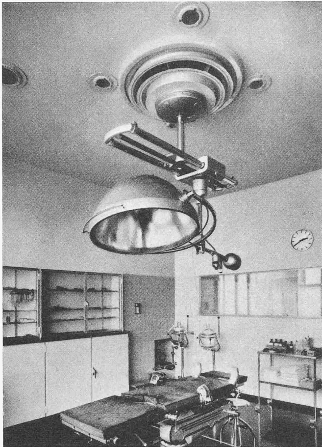
Bild 6. Operationslampe, darüber Zuluftzuführung.
