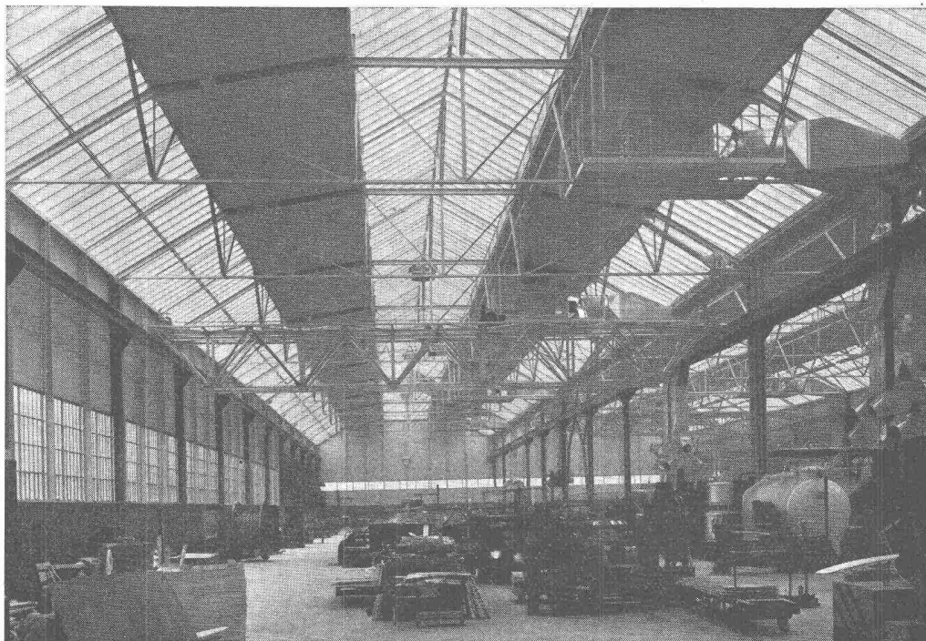
Produktionshalle, Krangerüst in Leichtmetall
