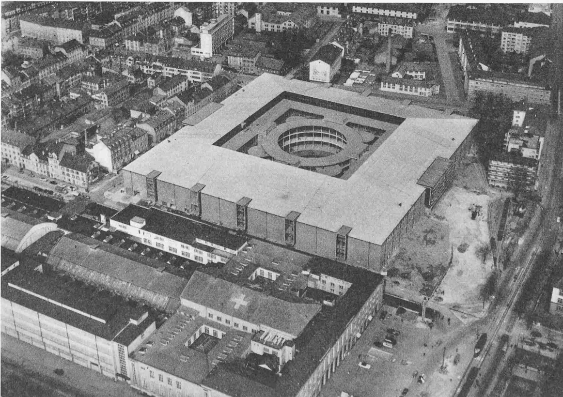
Bild 1. Fliegerbild aus Südwesten. Der Neubau von 400 000 m 3 bietet 50 000 m 2 Bodenfläche, wovon 20 000 m 2 Ausstellungsfläche und 30 000 m 2 Verkehrsflächen und Nebenraumfläche. Totale Baukosten 16 Mio Franken
