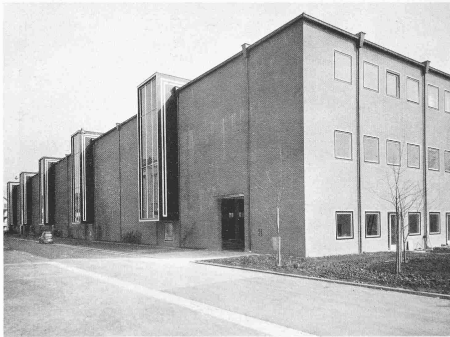
Fassade an der Isteinerstrasse (links) und Hauptfassade (rechts)
