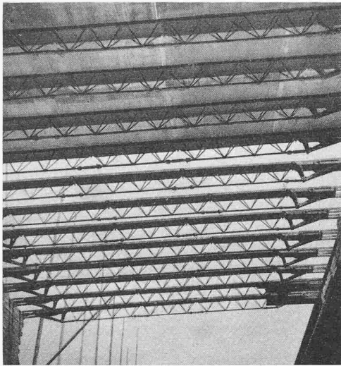
Bild 10. Hico Schalungsträger
