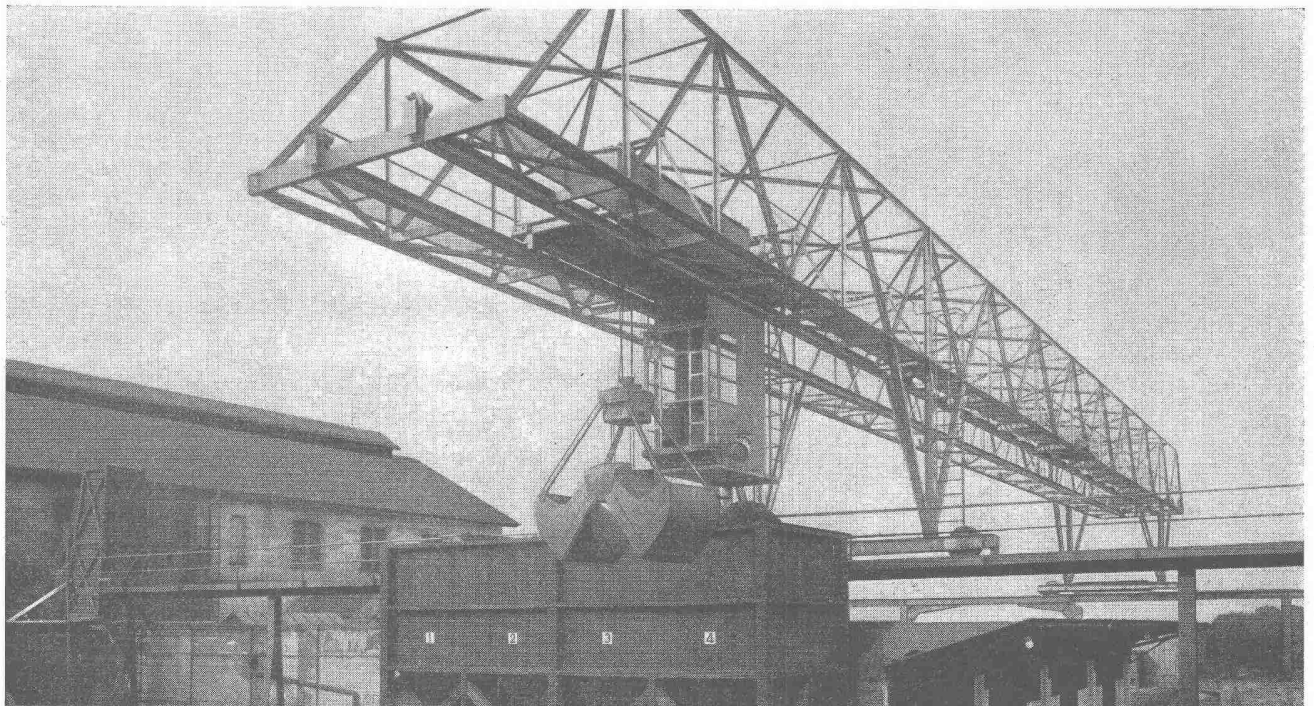
Verladebrücke in Schweisskonstruktion 2,5 t Tragkraft, 46 m Länge
