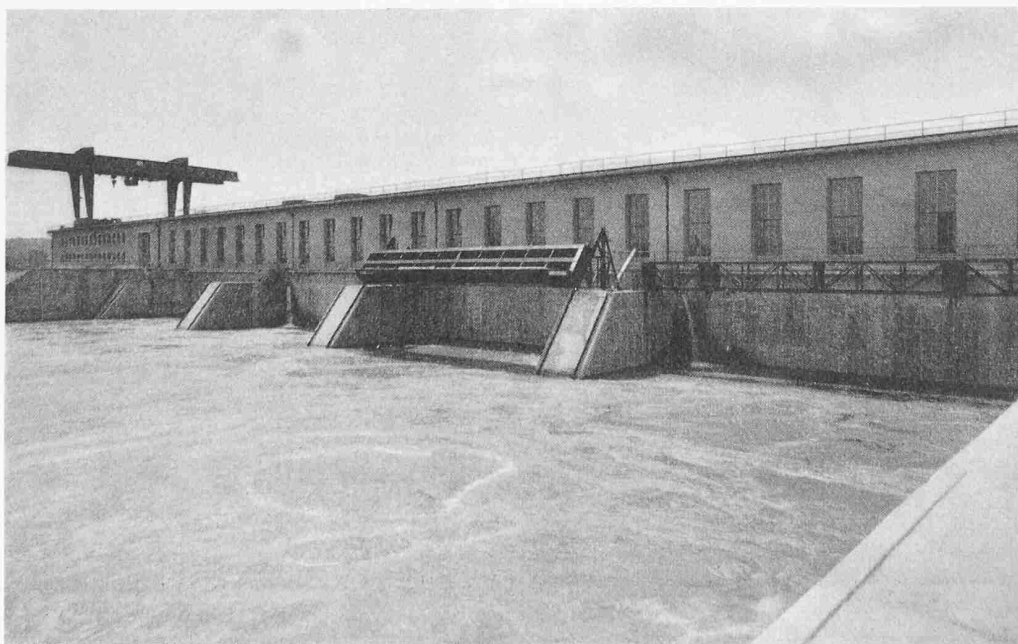
Bild 28. Ansicht des Krafthauses von der Unterwasserseite
