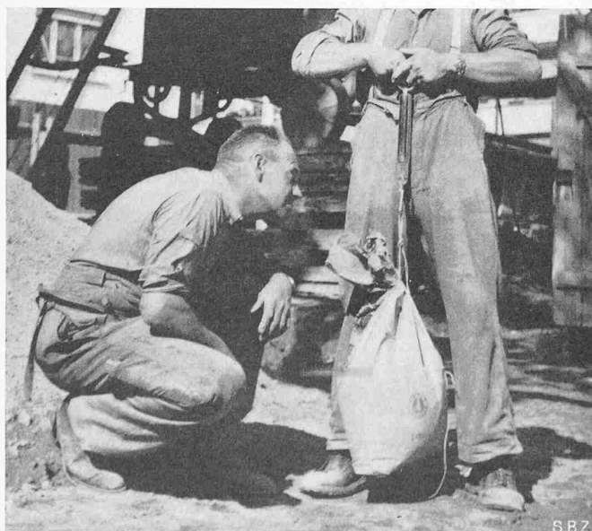
Bild 1. Wägen der Zementbeigabe mit Federwaage
