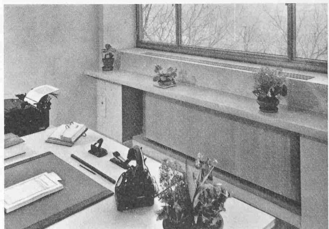
Bild 7. Einbau eines Jettair-Apparates in einem Bureauraum
