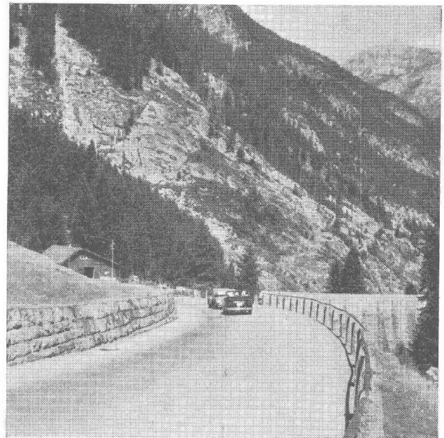
Gotthardstrasse mit CARPAVE-Belag
