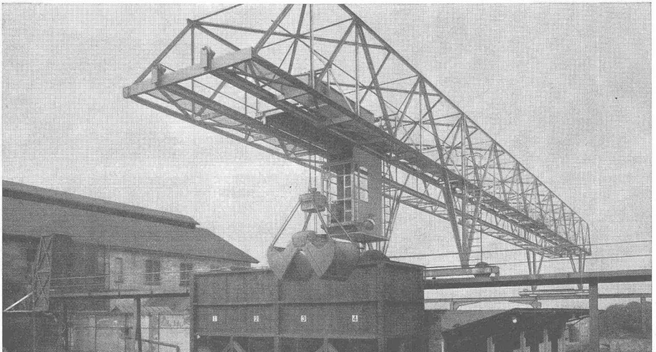
Verladebrücke in Schweisskonstruktion 2,5 t Tragkraft, 46 m Länge
