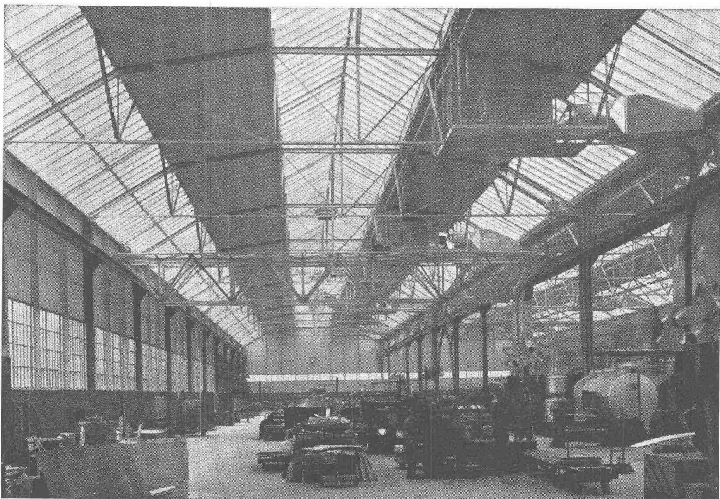
Produktionshalle, Krangerüst in Leichtmetall
