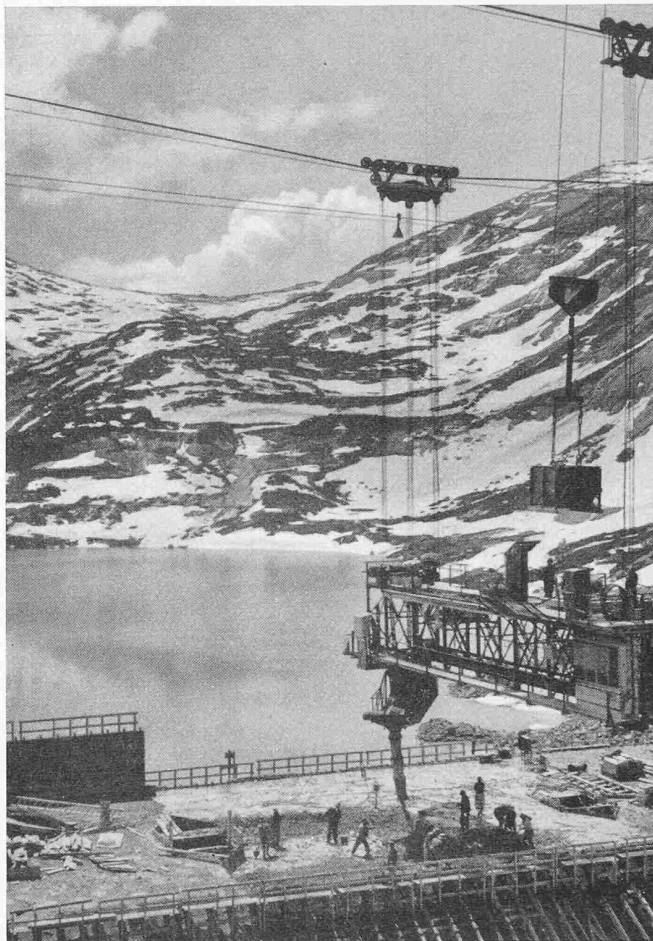
Bild 4. Verteilbühne für das Einbringen des Betons der Staumauer Räterichsboden
