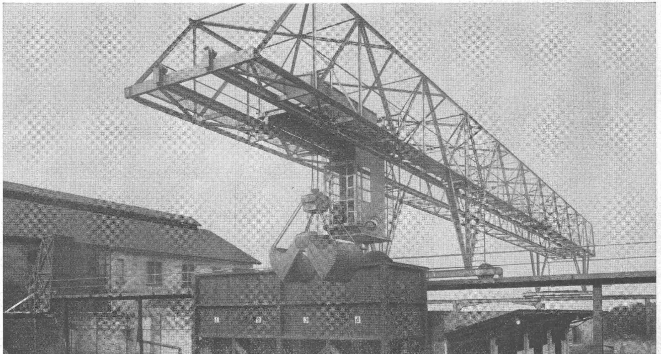
Verladebrücke in Schweisskonstruktion 2,5 t Tragkraft, 46 m Länge
