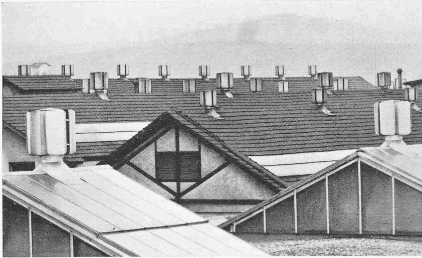
Bild 15. Falsche und richtige Ausbildung der Exhaustoren
