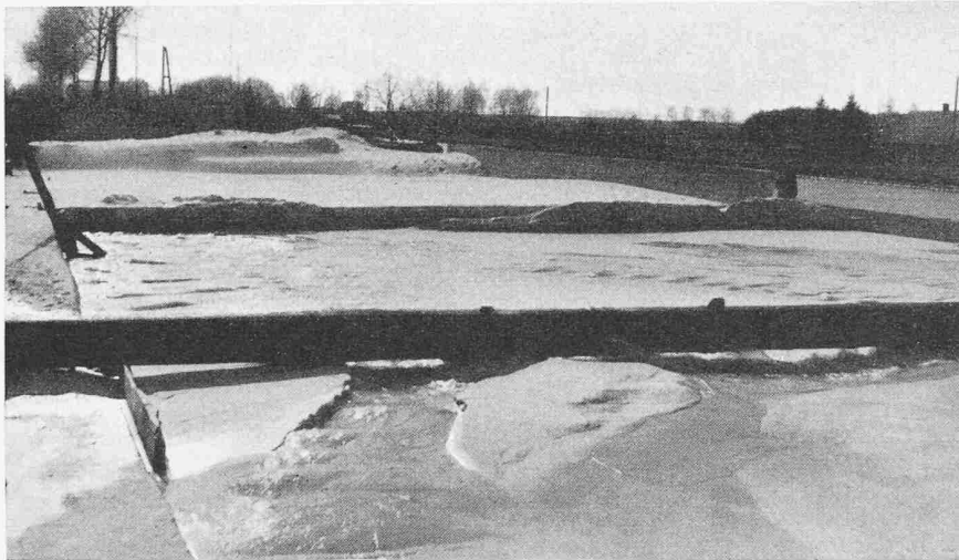
Bild 4. Transport durch Druckwasser in Beton-Silos
