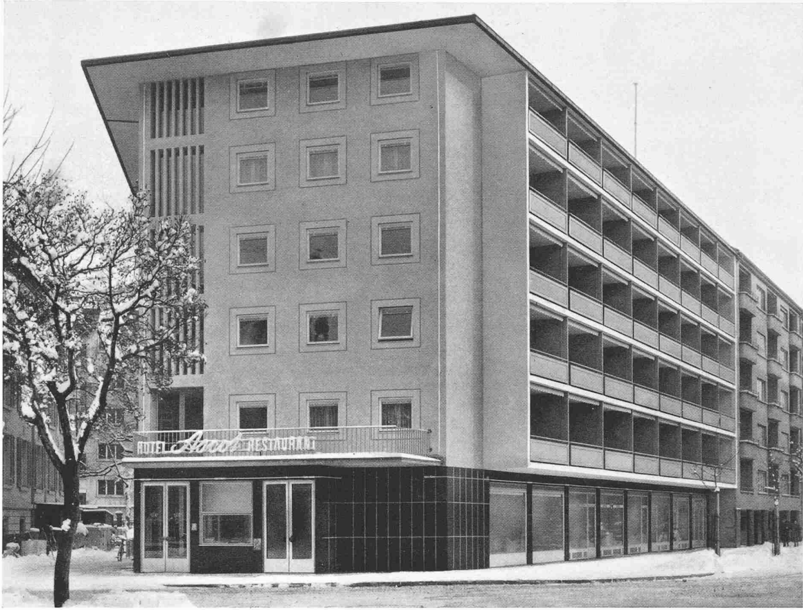
Ansicht von der Lavaterstrasse
