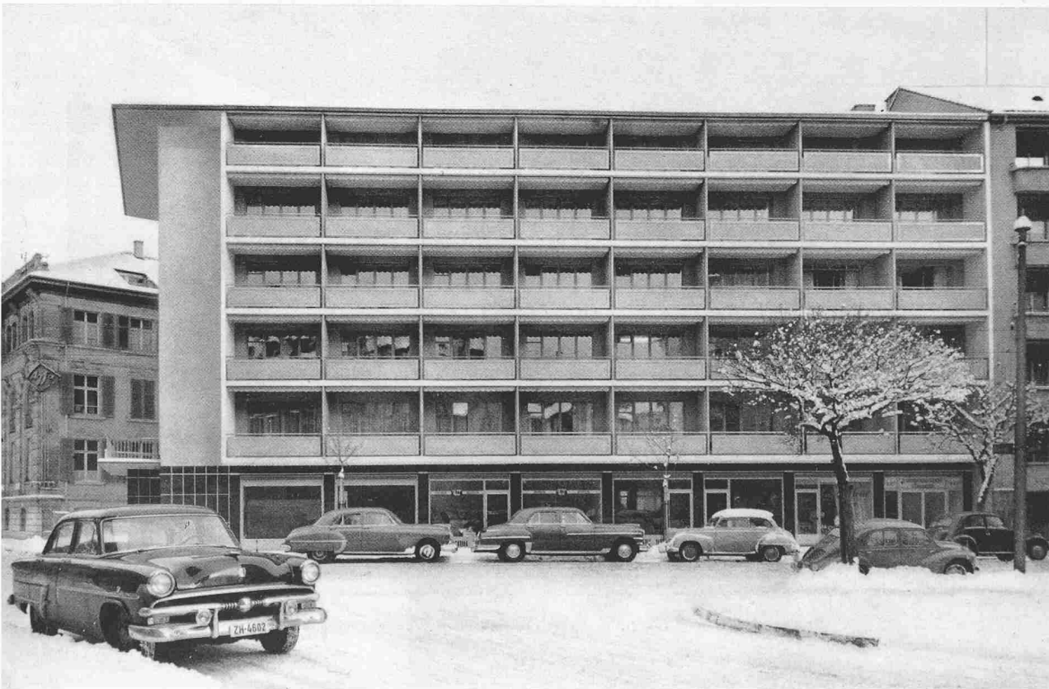
Ansicht von der General-Wille-Strasse
