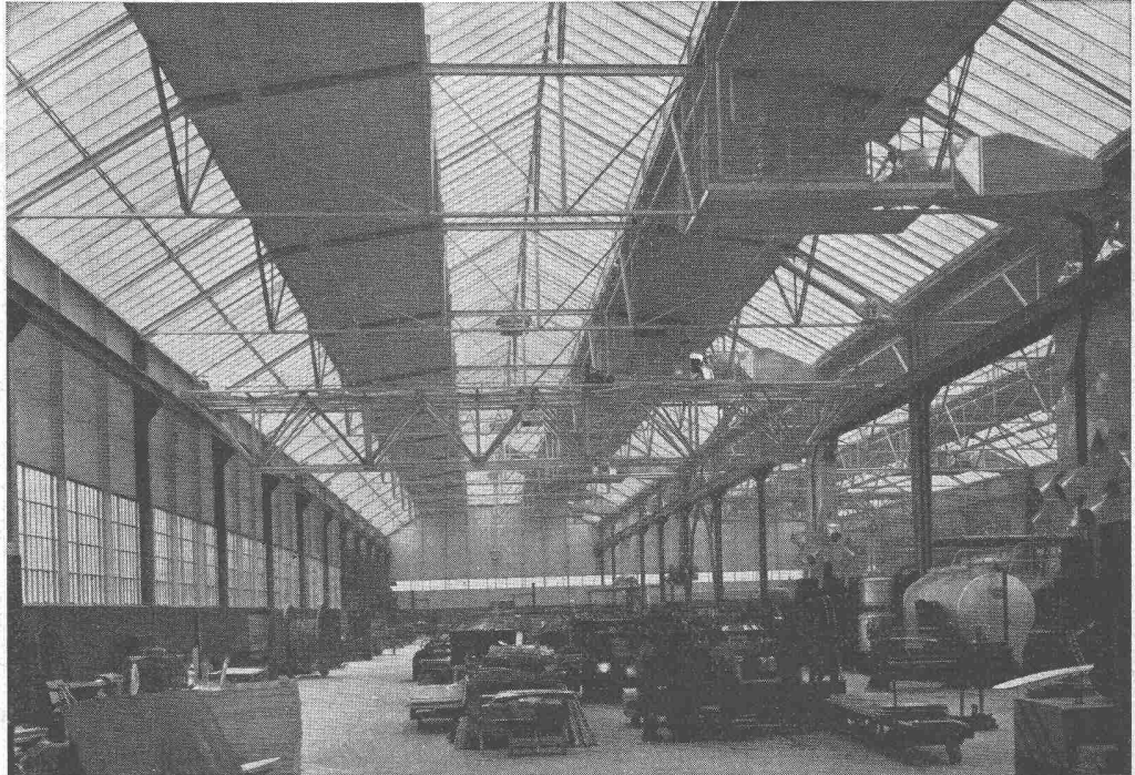
Produktionshalle, Krangerüst in Leichtmetall
