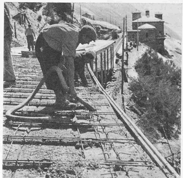
Bild 9. Betonierung des Troges über den Unterzügen
