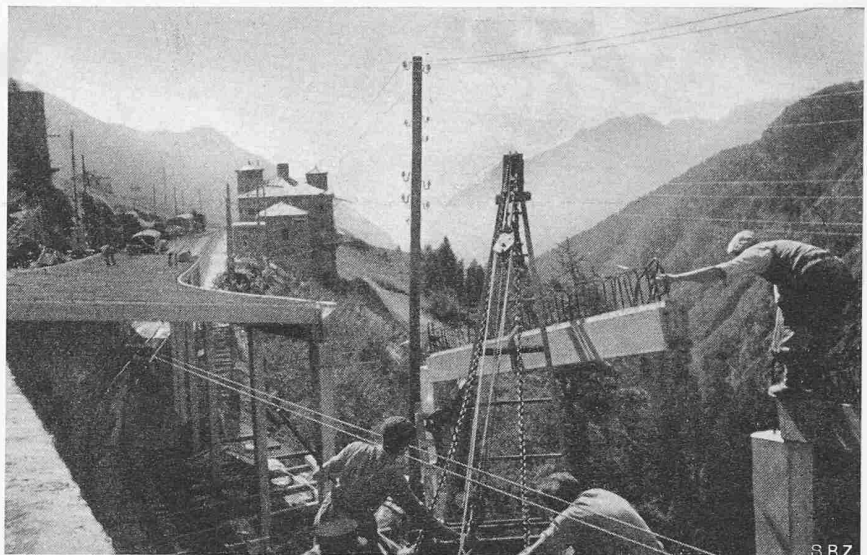
Bild 6. Versetzen eines Unterzuges
