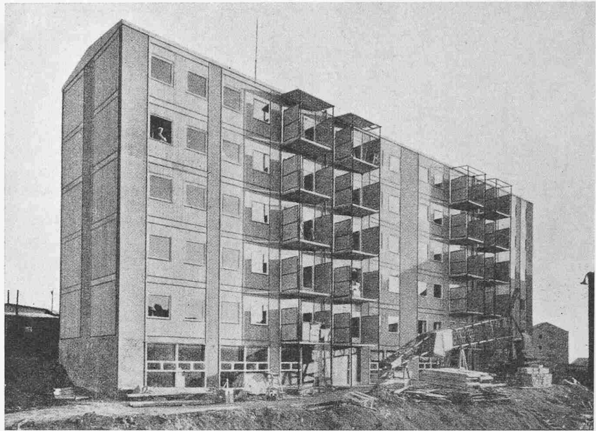
Bild 3. Fassade von Nordwesten
