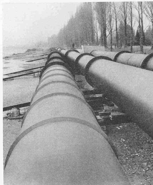
Fig. 13. Tronçons de la conduite sous-lacustre de 1600 mm sur la plage de montage
