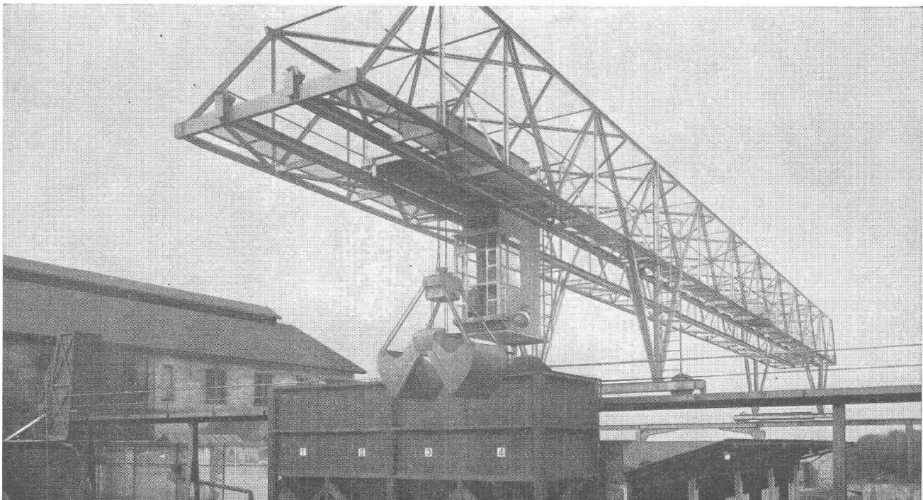
Verladebrücke in Schweisskonstruktion 2,5 t Tragkraft, 46 m Länge
