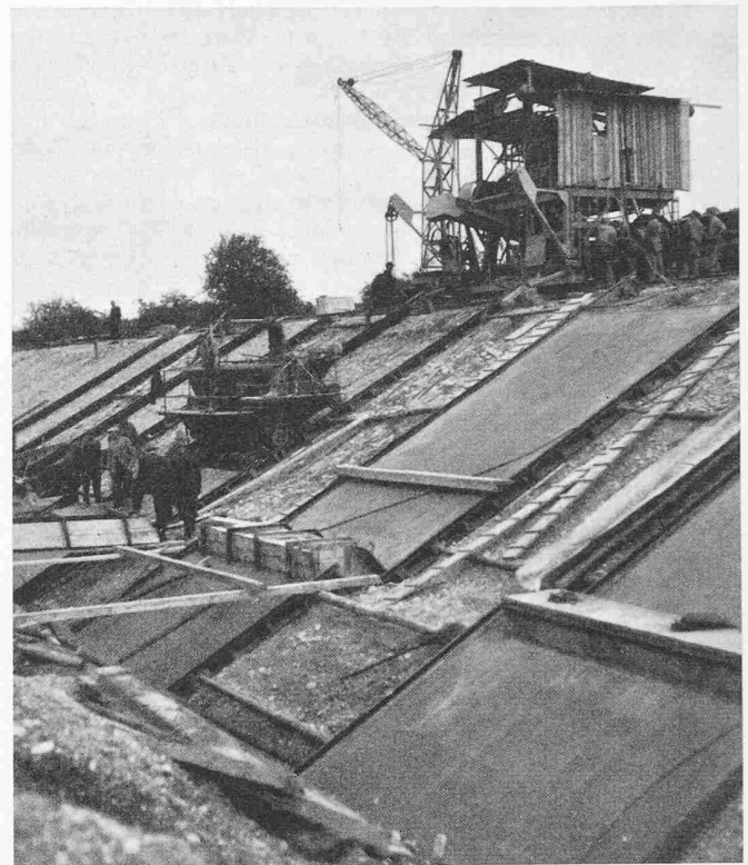
Bild 86. Betonieren einer Dammböschung im Staugebiet
