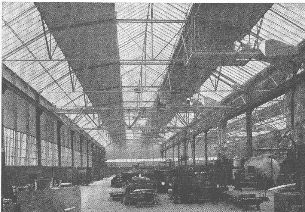
Produktionshalle, Krangerüst in Leichtmetall
