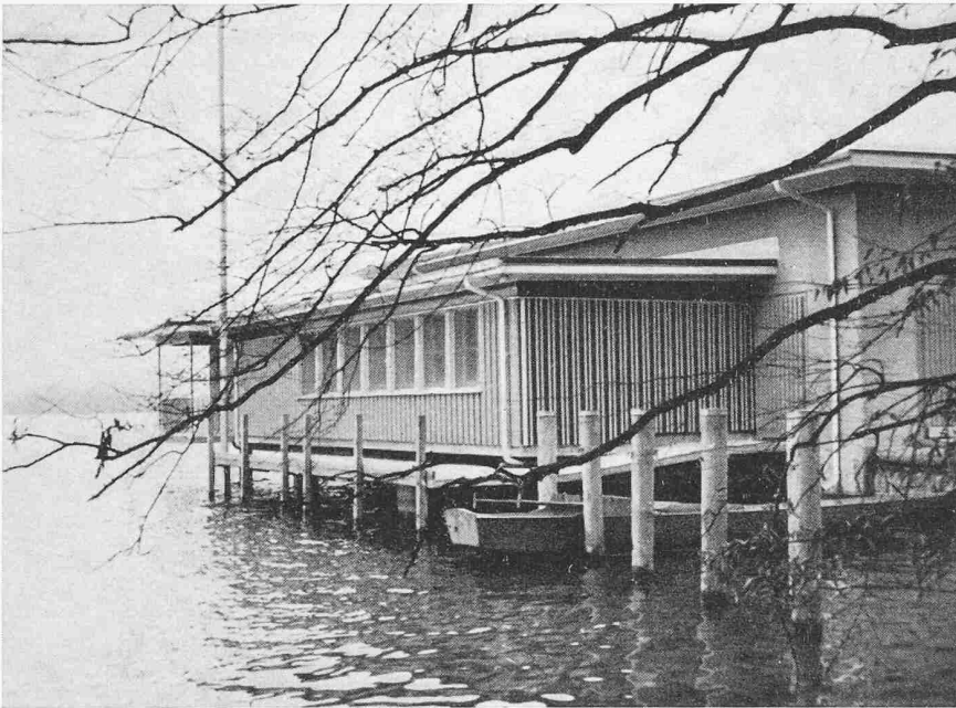
Ansicht des Nebenraumtraktes vom Land her
