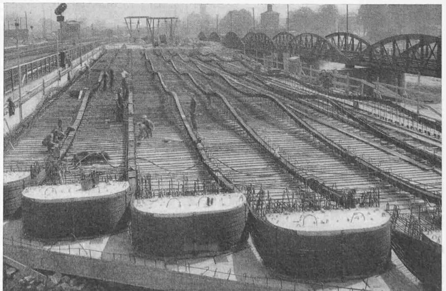
Bild 5. Gesamtansicht der verlegten Spannglieder der Eisenbahnbrücke über den Neckarkanal in Heilbronn. Erster Bauabschnitt des schiefen Bauwerkes durchlaufend über fünf Oeffnungen mit sieben Spannblöcken. Links sind die Spannglieder fertig, in der Mitte werden die Blechkasten geschlossen, rechts werden die Litzen verlegt. (vgl. auch Bilder 7 und 10)
