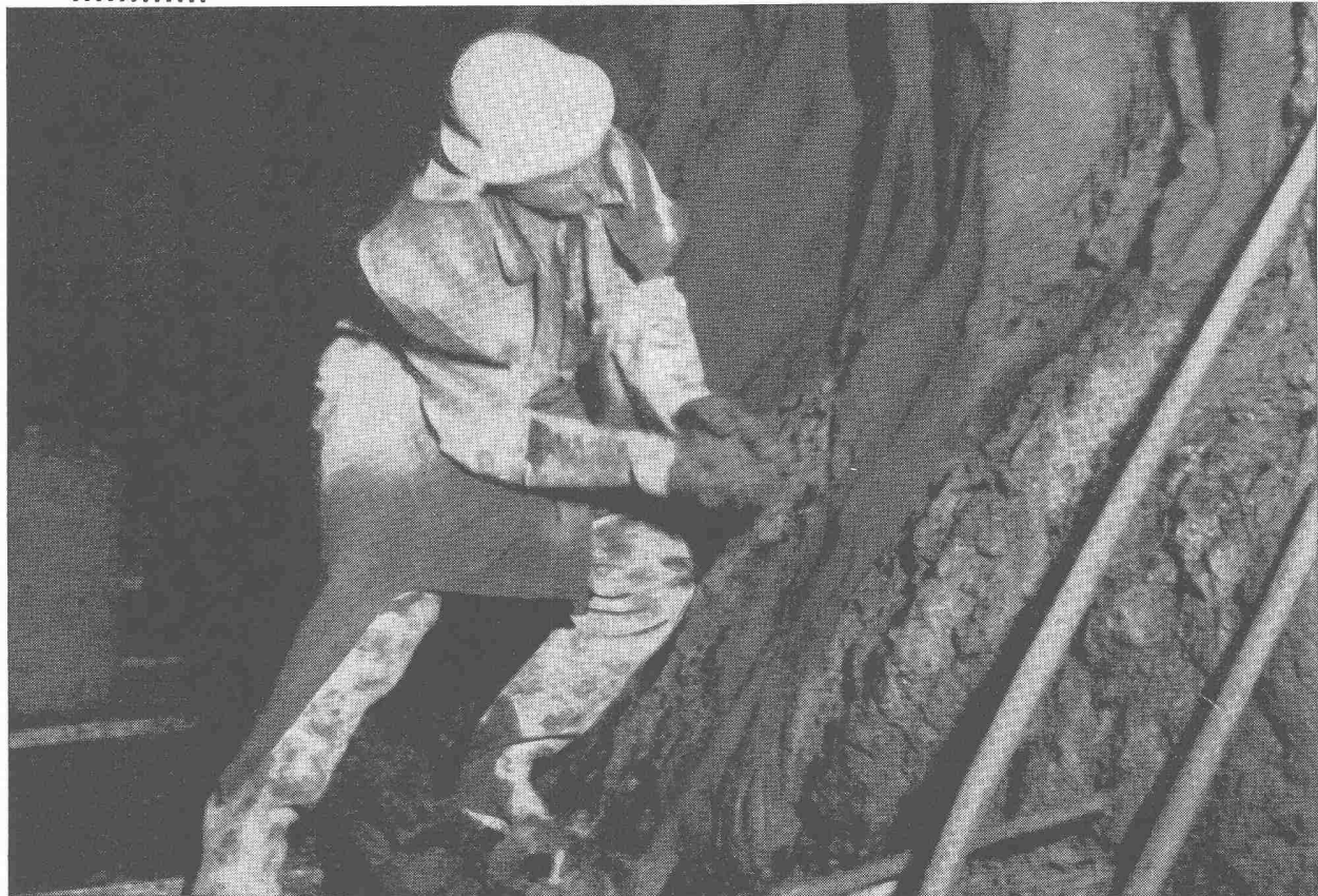
Maggia-Kraftwerke AG, Locarno. Vordichtung des Druckstollens Galleria Verbano mit BARRA-RAPID U.
