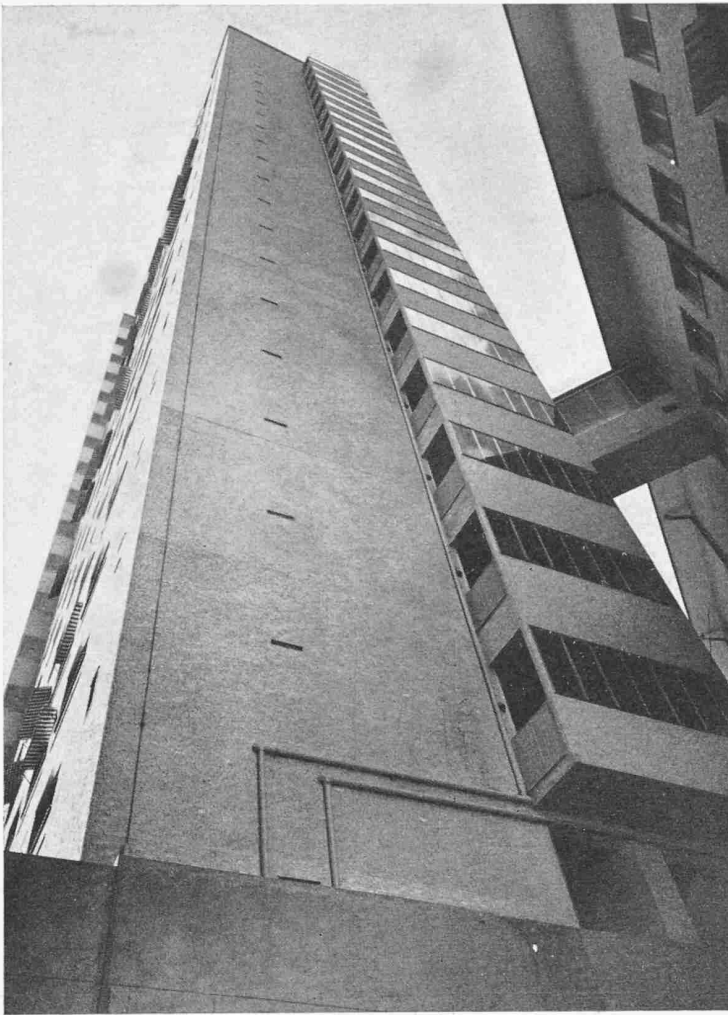
Bild 9. Hochhaus, Nordfassade, rechts Vorderbau
