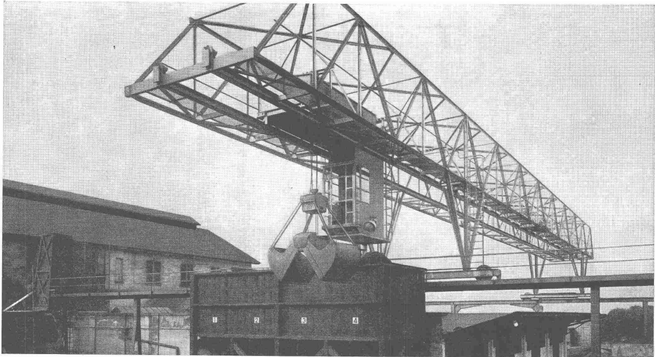
Verladebrücke in Schweisskonstruktion 2,5 t Tragkraft, 46 m Länge
