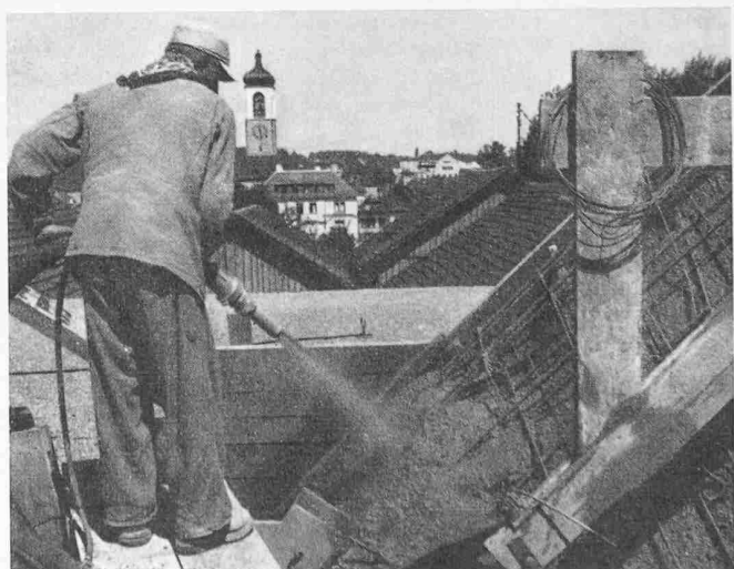
Bild 8. Betonieren nach dem Spritzverfahren der «Spribag», Zürich
