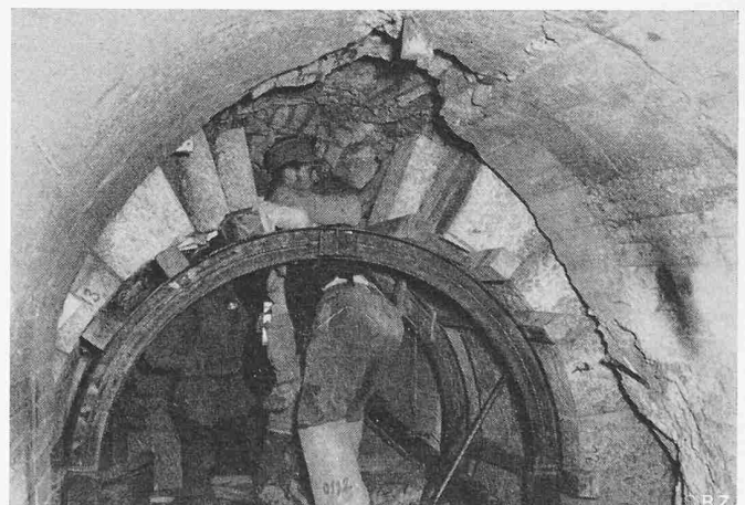
Fig. 14. Revêtement de granit en cours d'exécution (on distingue les briques éclatées du premier revêtement de béton)
