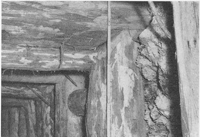
Fig. 3. On peut remarquer à droite l'écrasement du chapeau sur la pointelle. La roche molle flue autour de la pointelle de droite
