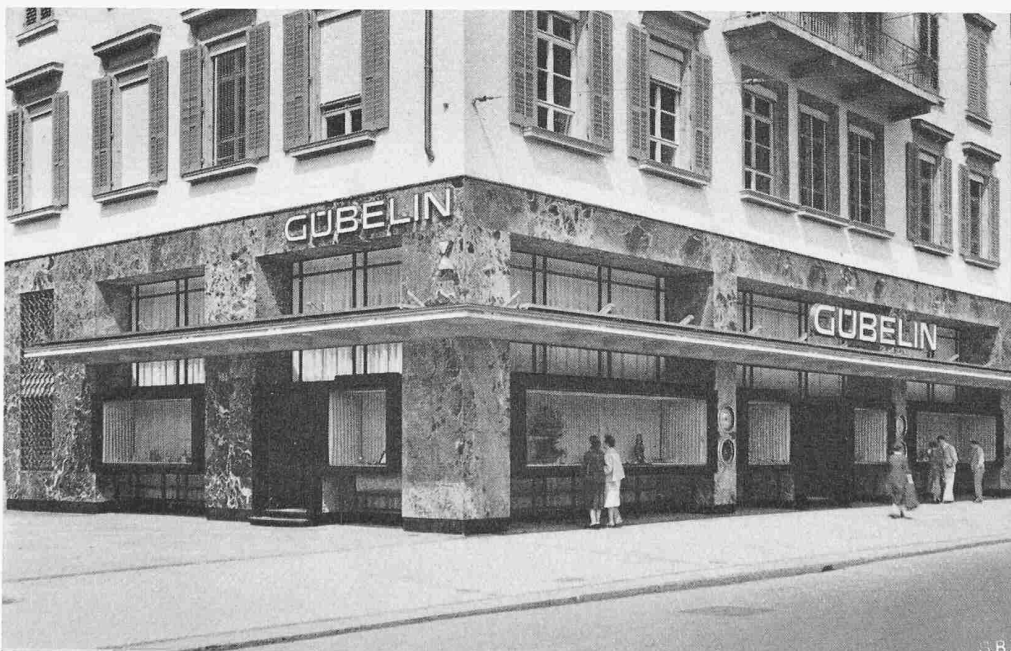
Bild 4. Der Ladeneinbau im renovierten Geschäftshaus am Schweizerhofquai in Luzern
